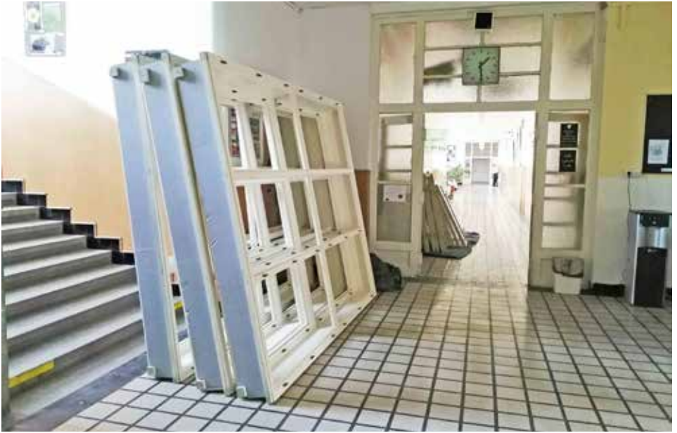
Nová okna na hlavní schodiště
