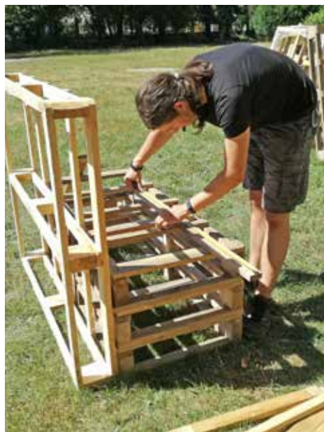
Stavba venkovního posezení na zahradě školy
